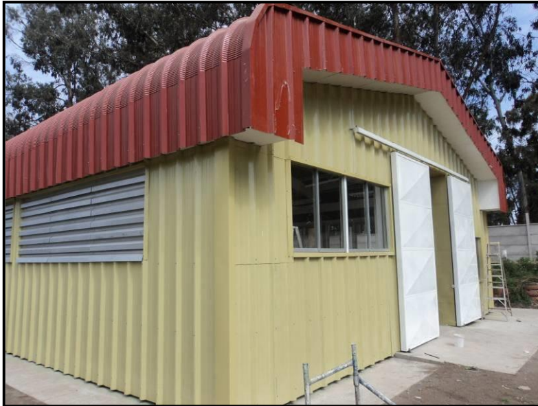
Figura N° 6: Galpón de separación, Centro de Acopio San Antonio
